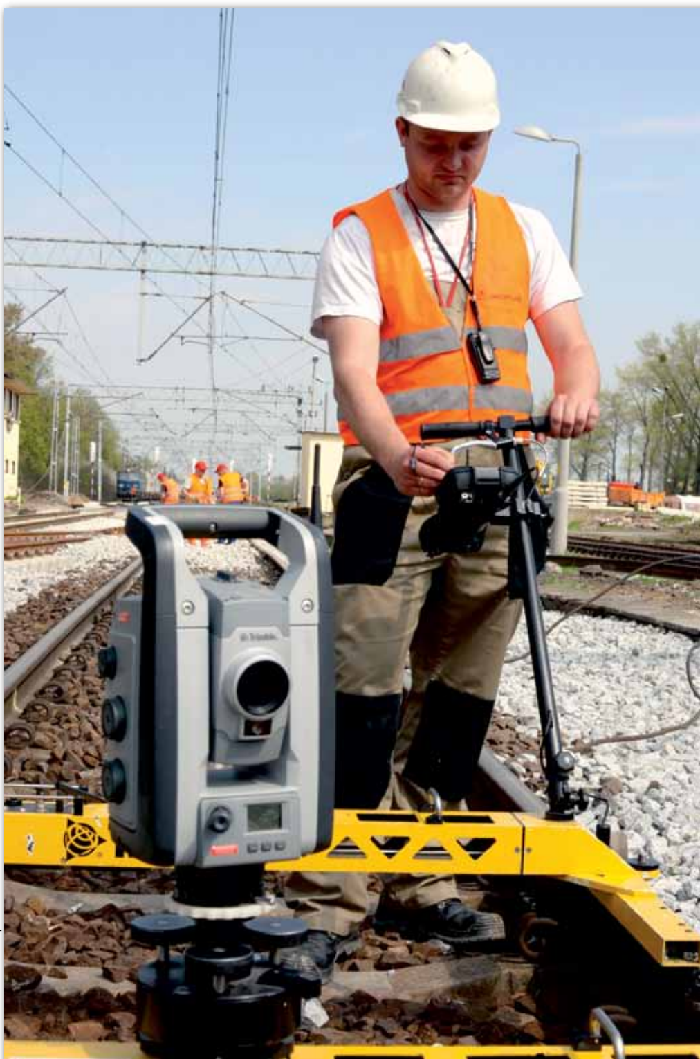
Pomiar torów za pomocą systemu Trimble GEDO podczas modernizacji linii nr 1 na odcinku Koluszki – Częstochowa
